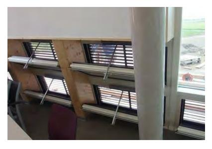
Fig. 10 BOTTOM-HUNG PROJECTING-IN OPENINGS, SOURCE: ARCHITEKTURBÜRO REINBERG ZTGMBH
